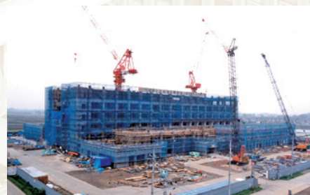
新病院建設工事中
